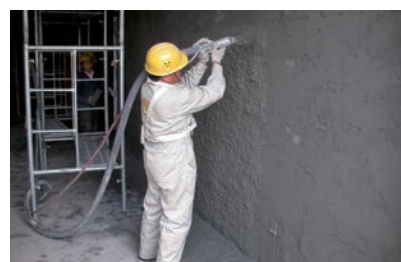
Набрызг внутренней штукатурки
