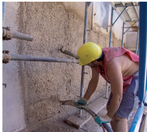
Набрызг наружной штукатурки
