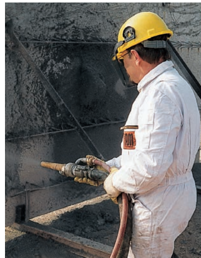
Торкрет-бетон, до 8 мм
