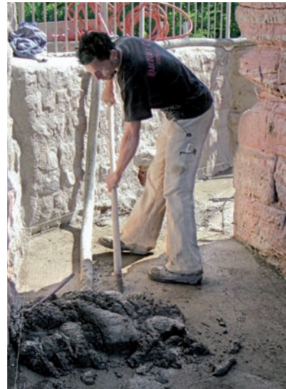
Перекачивание мелкозернистого бетона с фракцией
