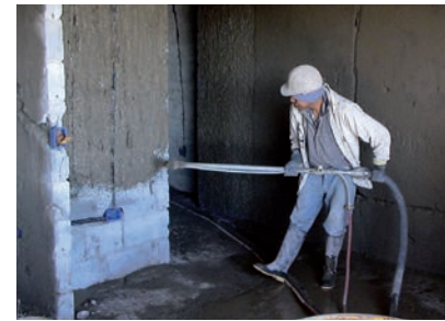
Набрызг внутренней штукатурки
